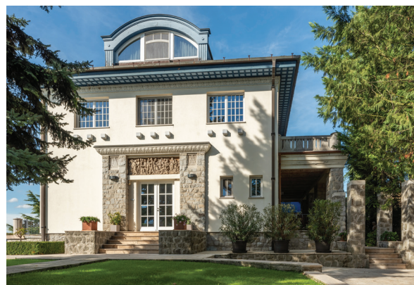
Az épület déli homlokzata, 2024 (fotó: Gulyás Attila)
